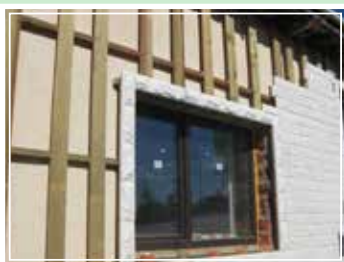
Монтаж под окрас
